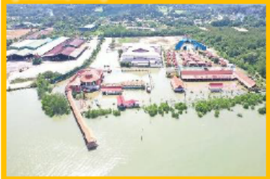
Foto udara Jetty Minyak Beku (NAHRIM, 2021)
